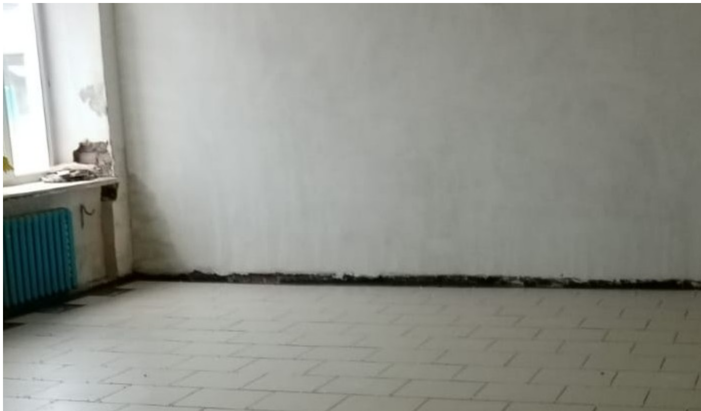
Фото 1- «укладка плитки в коридоре второго этажа»
