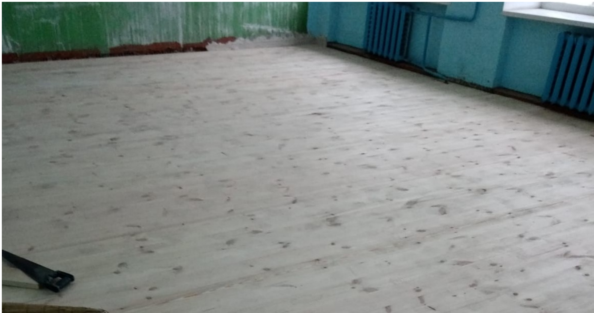
фото 2 – «укладка деревянных полов в кабинетах второго этажа»
