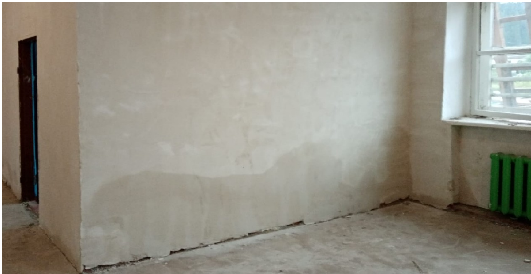
Фото 4 – «штукатурка стен 1 этажа»
