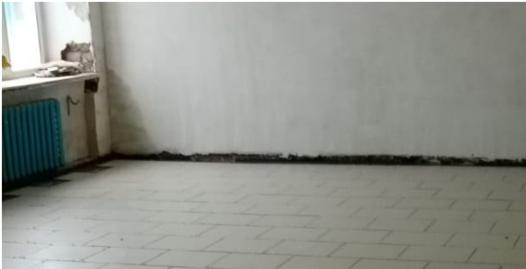
Фото 3 – «укладка плитки в гардеробе»
