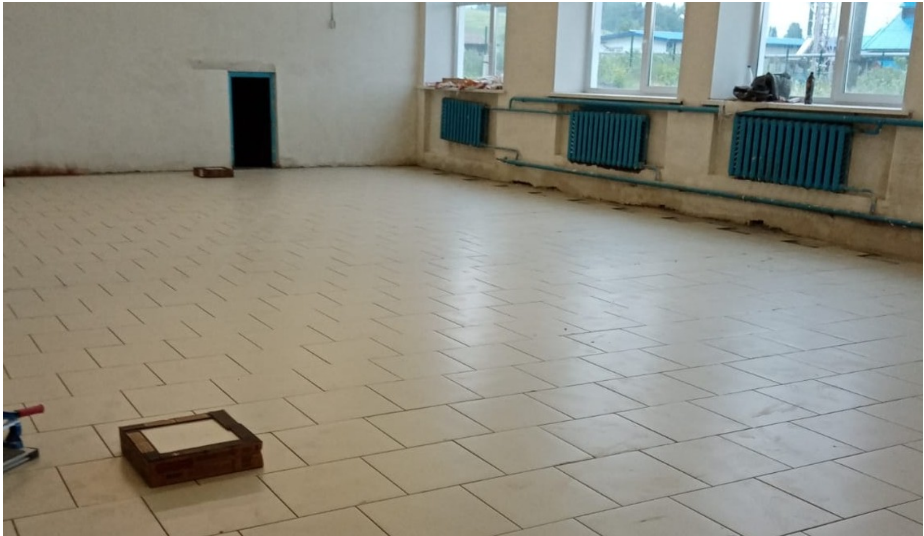
Фото 5 – « укладка плитки в обеденном зале»
