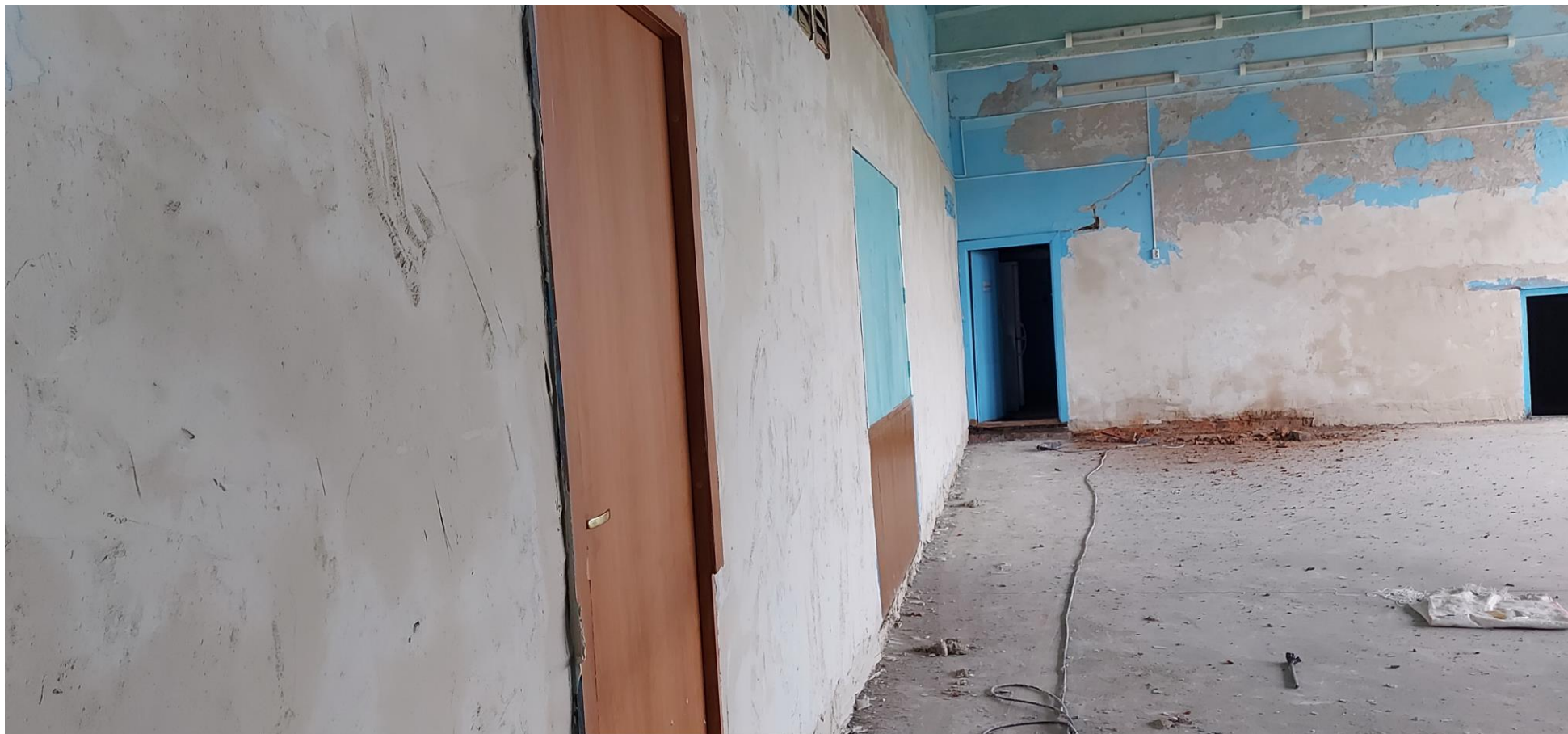
Фото 4 – «выравнивание стен в обеденном зале»
